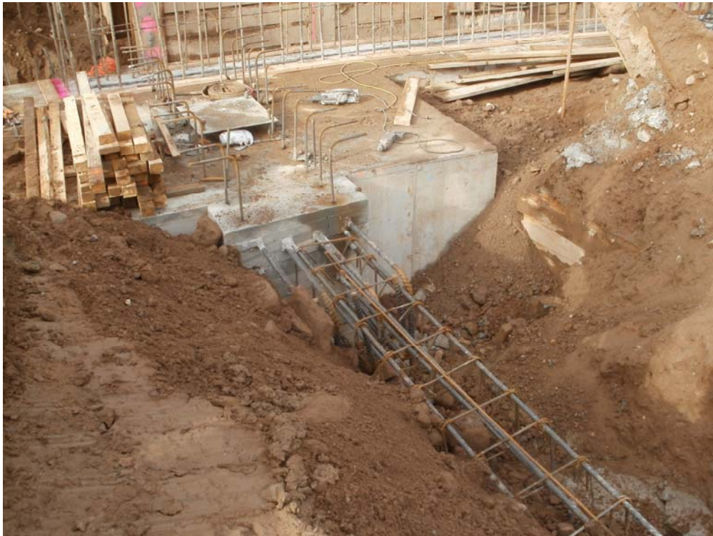
6. Reinforcing for grade beam concrete pour
